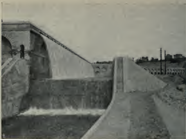
IMPIANTO IDRO-ELETTRICO DI VIZZOLA-TICINO. — Bacino di presa.
